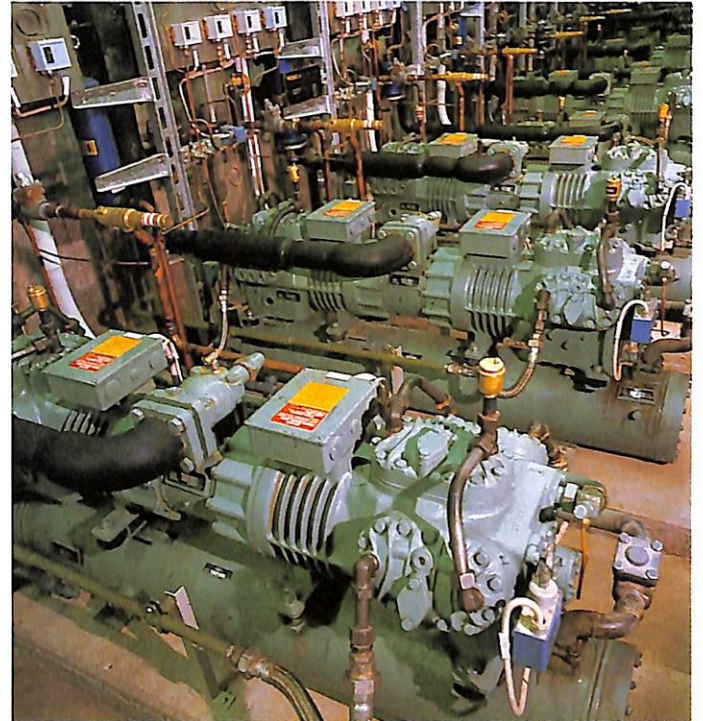
Eine Batterie von elf Kompressoren mit einer Gesamtleistung von 600 kW ermöglicht Versuche in den Kälteprüfständen bis -35^{\circ}\text{C} und im Klimaprüfstand für einen simulierten Fahrbetrieb bis -30^{\circ}\text{C} .
